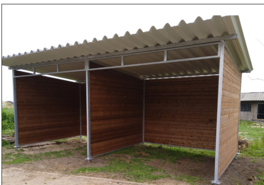
Skillevæg monteret i læskur
