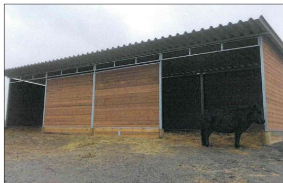
Frontvægge monteret i læskur
